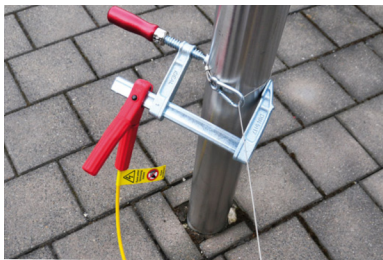
Mise à la terre sur le mât à l'aide d'un collier à vis
